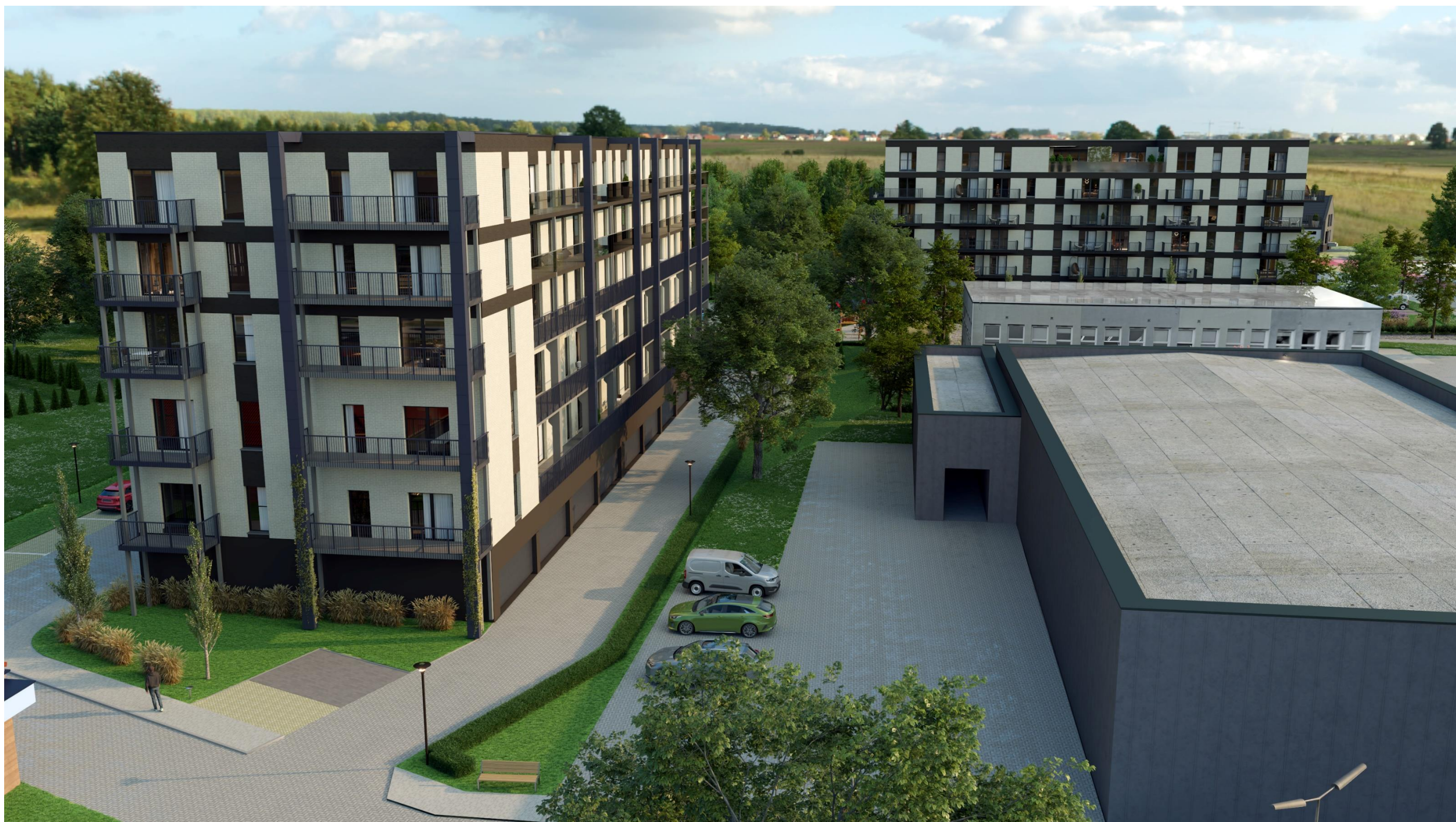
KONCEPCJA ARCHITEKTONICZNO-URBANISTYCZNA ZESPOŁU 2 BUDYNKÓW MIESZKALNYCH WIELORODZINNYCH PRZY UL. FROMBORSKIEJ WIZUALIZACJA BUDYNKU NR 1 I 2 W OTACZAJĄCEJ ZABUDOWIE ISTNIEJĄCEJ
