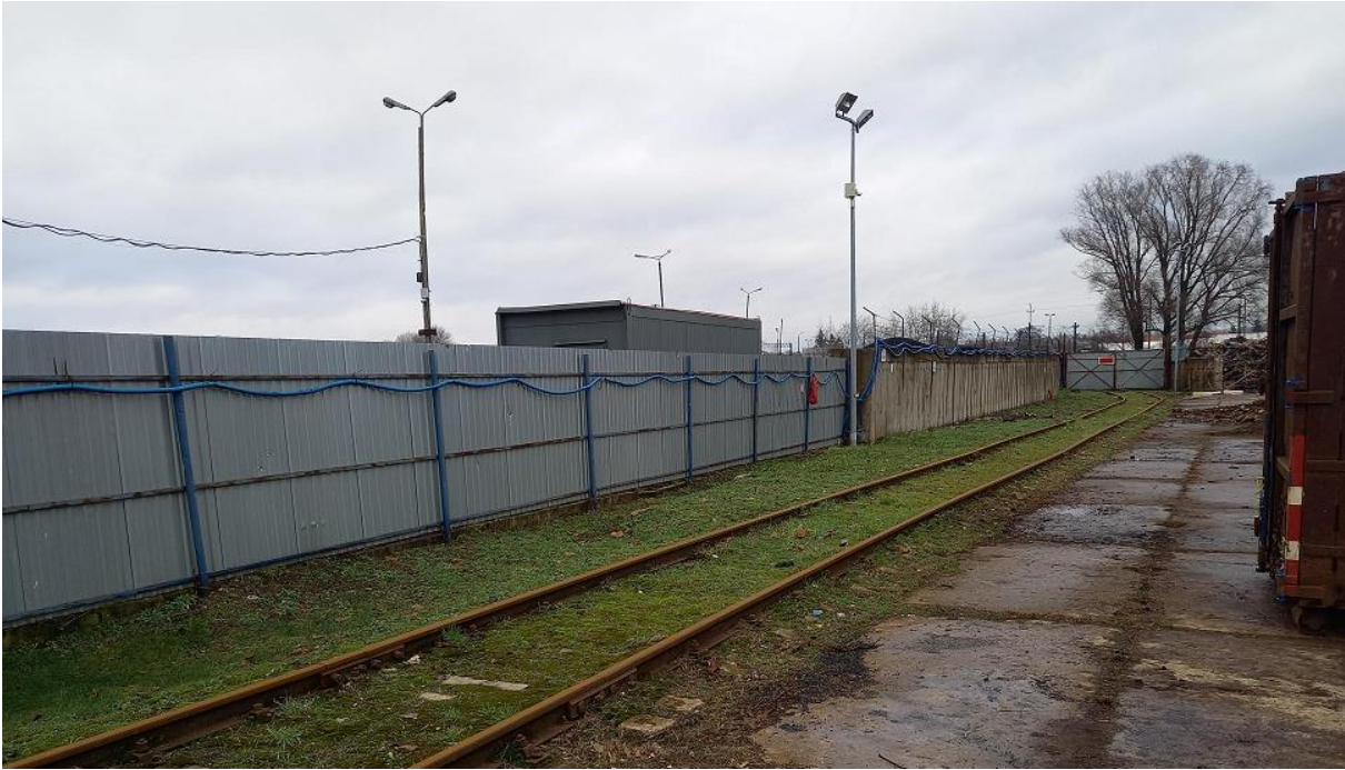
Fotografia 1. Teren planowanego przedsięwzięcia – obszar załadunku odpadów na wagaony.
