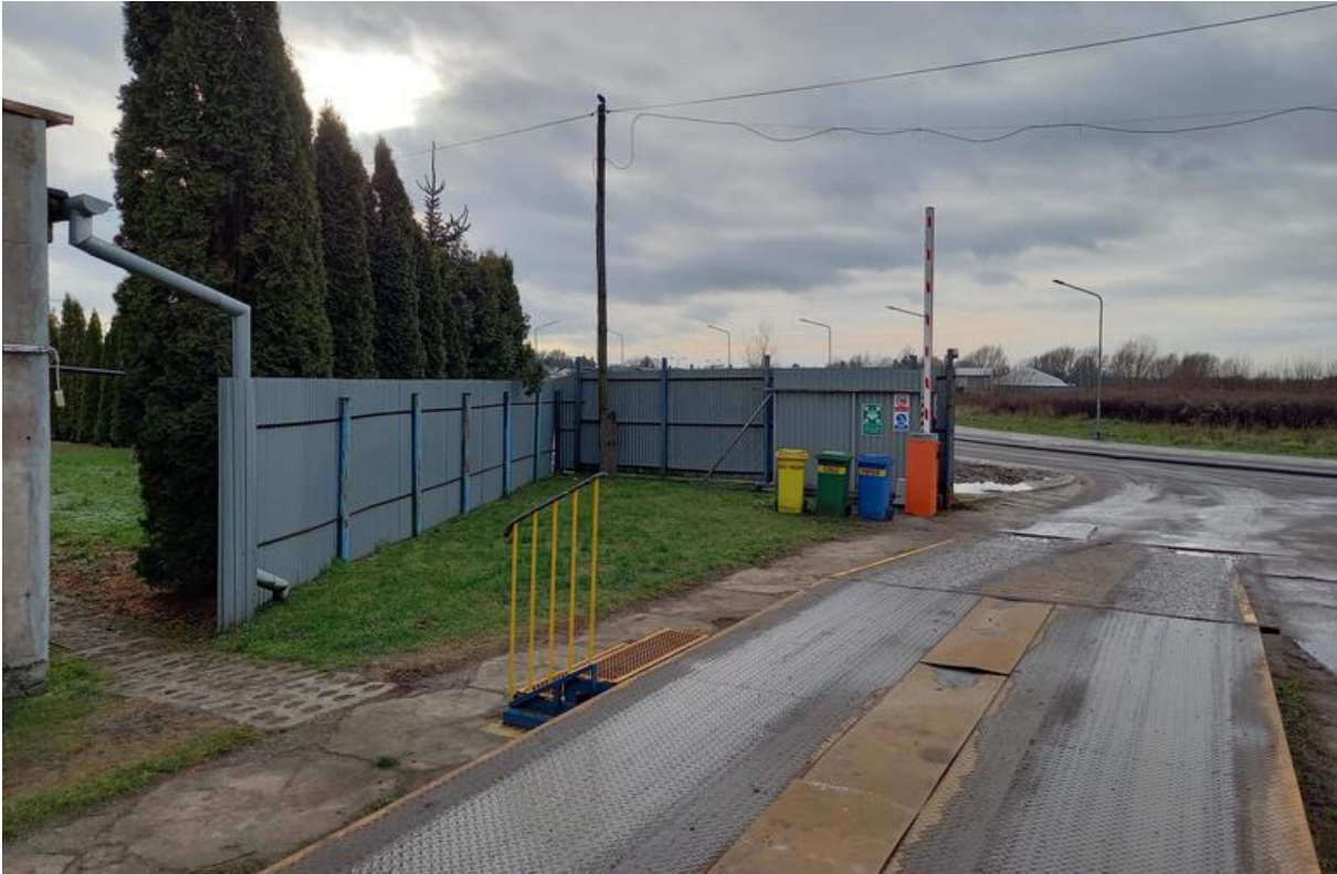
Fotografia 3. Teren planowanego przedsięwzięcia – brama wjazdowa i waga najazdowa
