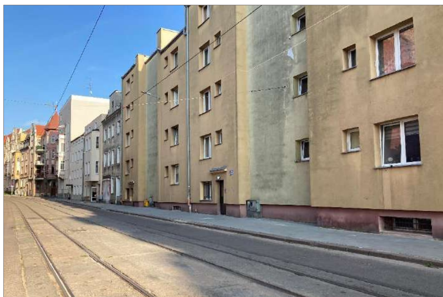
Fotografia 14. Zróżnicowanie nawierzchni przy ulicy Królewieckiej
