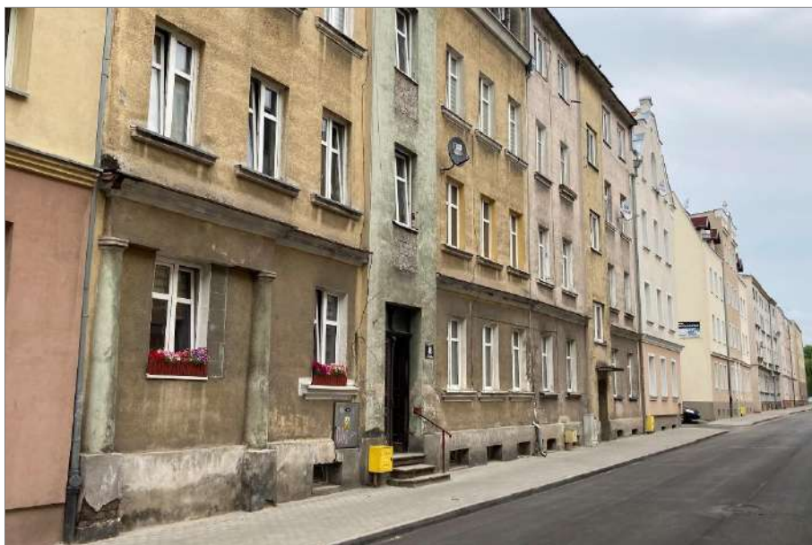
Fotografia 4. Zespół budynków mieszkalnych przy wyremontowanej ulicy Wyspiańskiego
