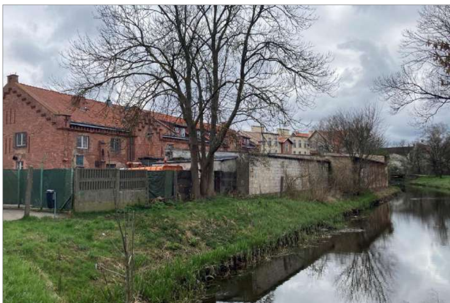
Fotografia 9. Zachowana zabudowa Wyspy Spichrzów obok fosy miejskiej
