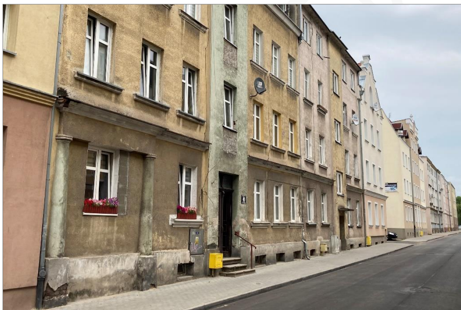
Fotografia 4. Zespół budynków mieszkalnych przy wyremontowanej ulicy Wyspiańskiego
