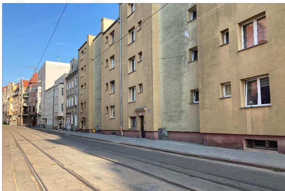
Fotografia 14. Zróżnicowanie nawierzchni przy ulicy Królewieckiej
