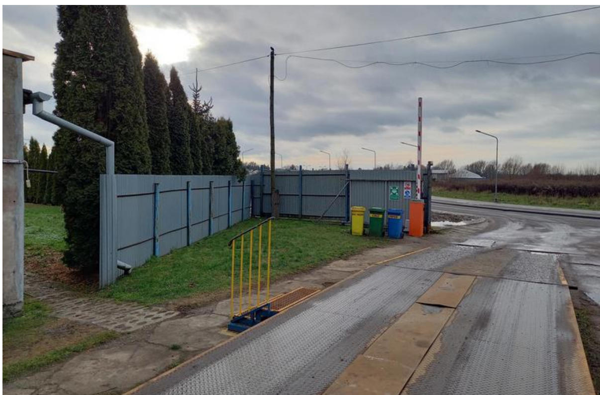
Fotografia 3. Teren planowanego przedsięwzięcia – brama wjazdowa i waga najazdowa
