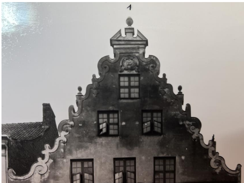
Detal szczytu kamienicy przy ul. Św. Ducha 1
